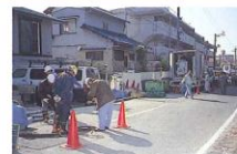
●蒸気加熱状況
